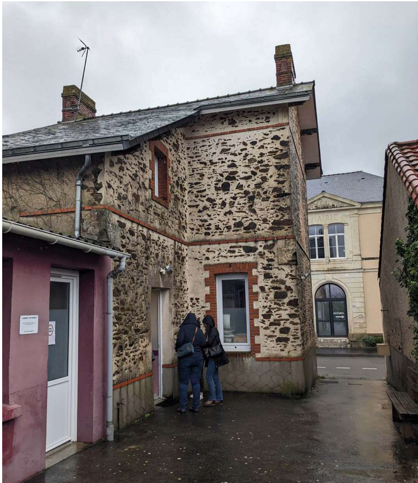
L'ancienne poste vue de la courette intérieure, avec la mairie en fond
