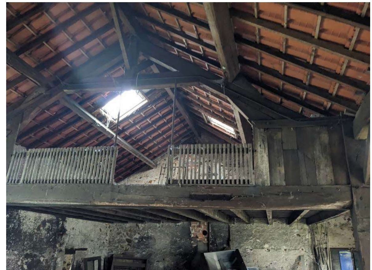
L'intérieur du bâtiment principal et sa mezzanine
