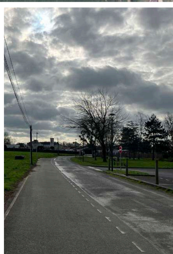
Route de la Mouchetière, à l'ouest du site
